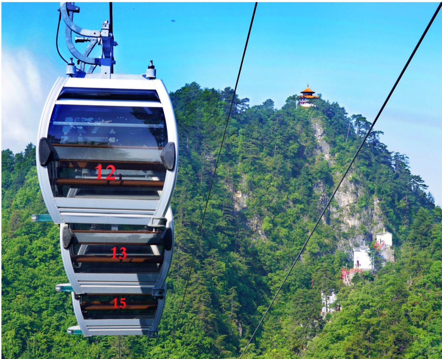
Канатная дорога с импульсным движением на горе Таюнь, провинция Шэньси, Китай. Горизонтальное расстояние: 693,31 м Перепад высот: 77.2m Скорость: 0-4,0 м/с Производительность: 525 чел/час
